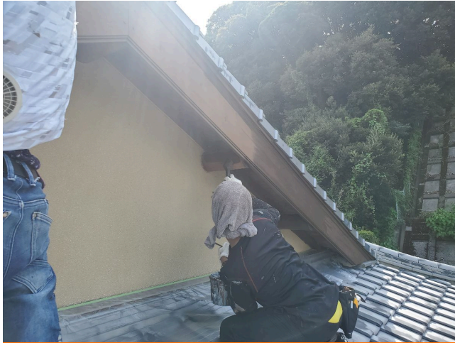
木部破風板 1回目塗装
