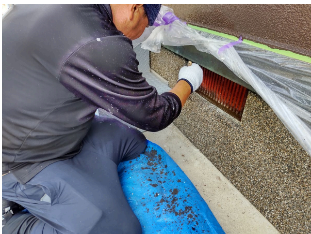
鉄部各所 錆止め塗装
