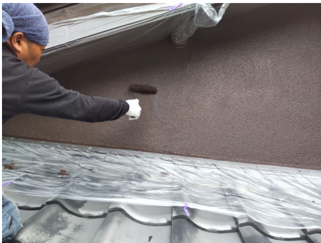
外壁 上塗2回目塗装
