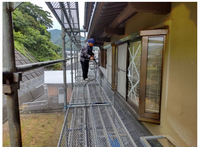
外壁 高圧水洗浄
