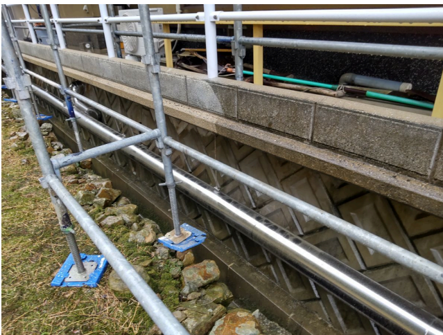
外壁 高圧水洗浄
