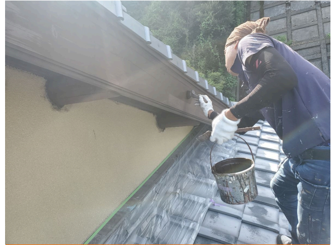
木部破風板 2回目塗装
