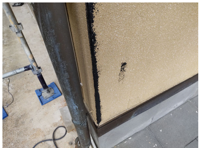
外壁剥離箇所 補修
