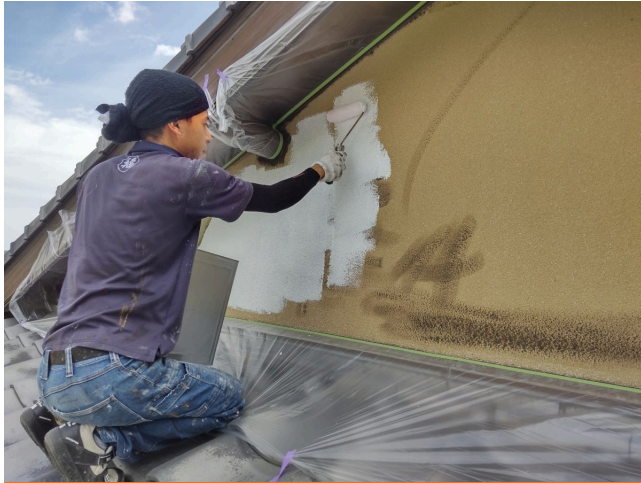
外壁 下塗塗装
