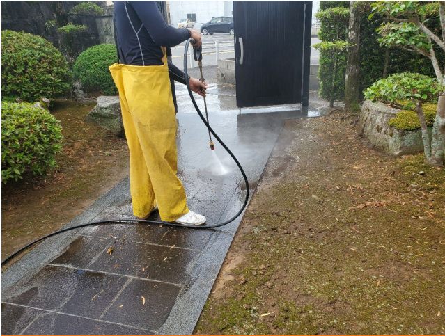
土間、塀 高圧水洗浄
