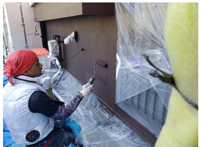
外壁 上塗2回目塗装
