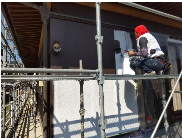
外壁 上塗1回目塗装
