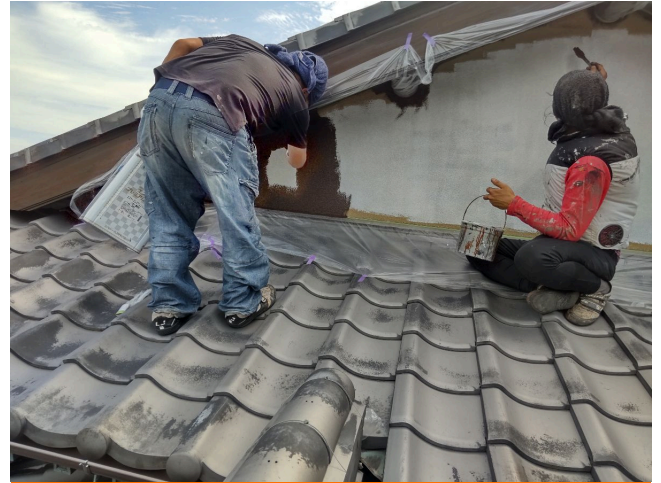
外壁 上塗1回目塗装
