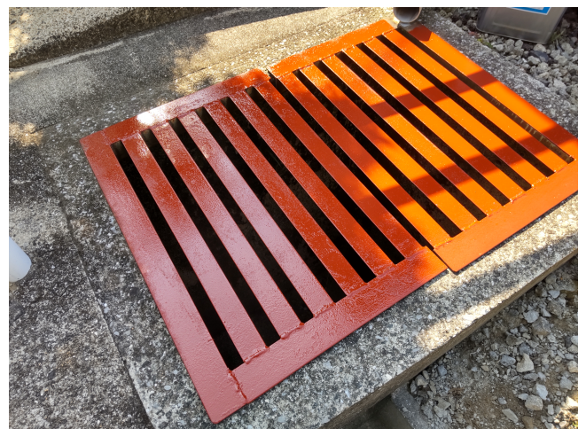
鉄部各所 錆止め塗装
