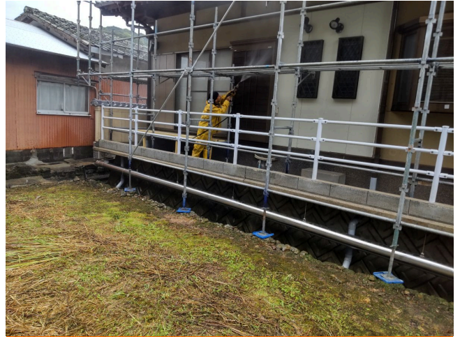
外壁 高圧水洗浄
