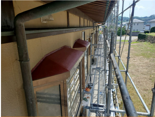
出窓天板 錆止め完了
