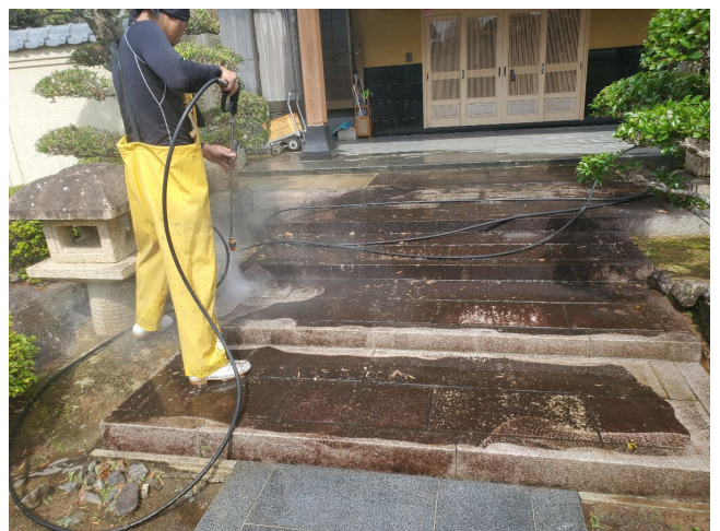
土間、塀 高圧水洗浄
