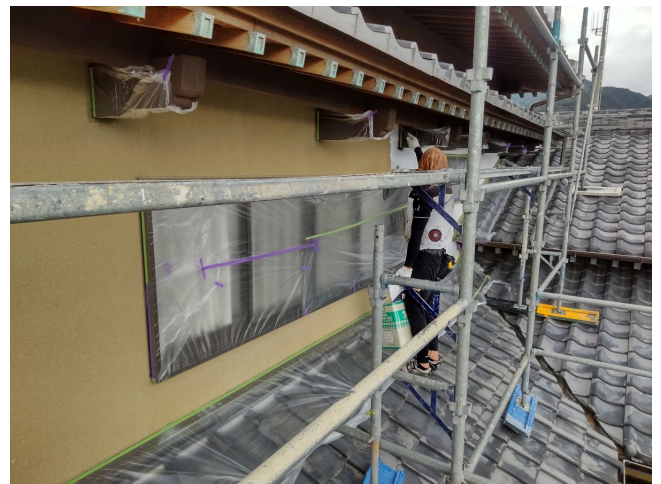
外壁 下塗塗装
