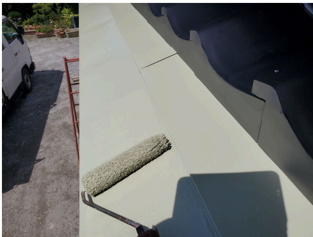
上塗2回目塗装状況
