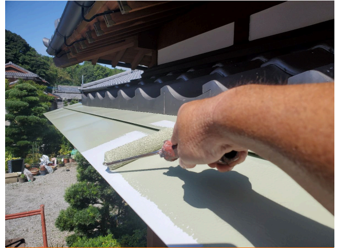
上塗1回目塗装状況
