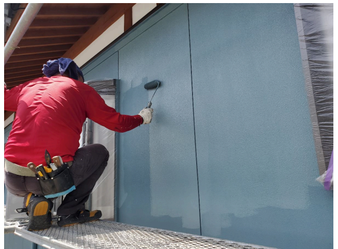
外壁 上塗2回目塗装状況
