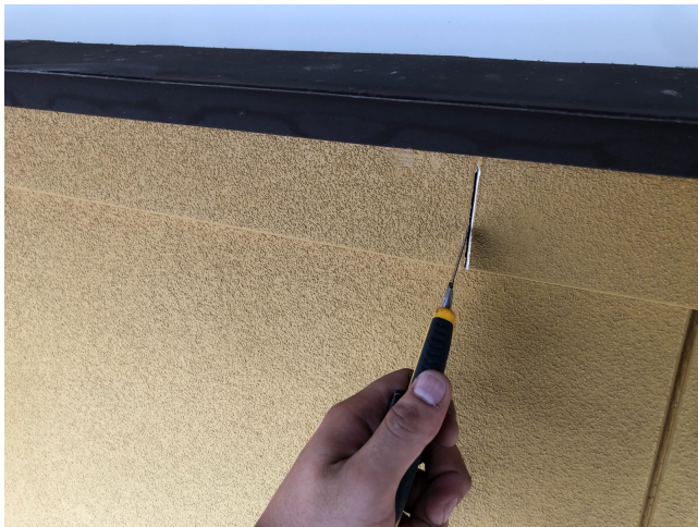
シール劣化部除去
