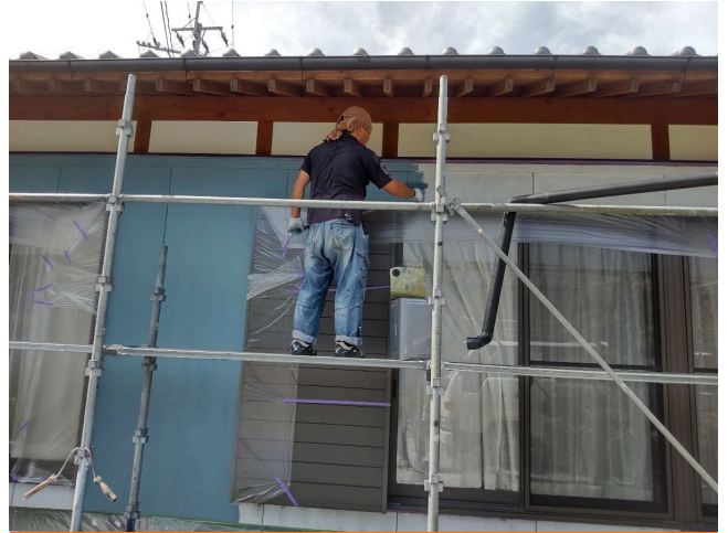
外壁 上塗1回目塗装状況
