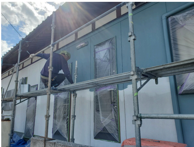
外壁 上塗1回目塗装状況
