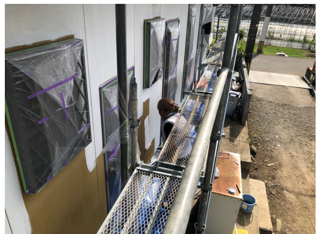
外壁 下塗塗装状況
