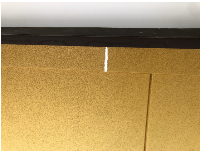
シール充填完了
