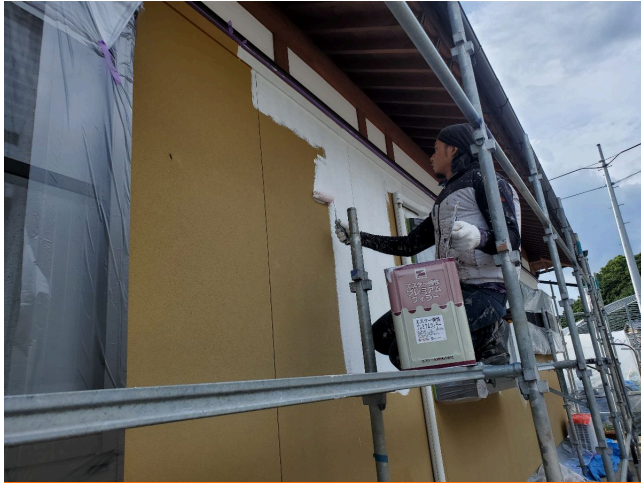
外壁 下塗塗装状況
