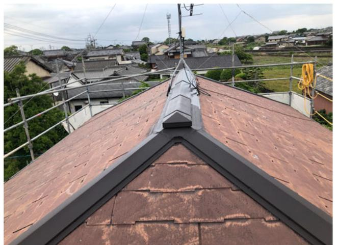
屋根 棟板金 錆止め完了
