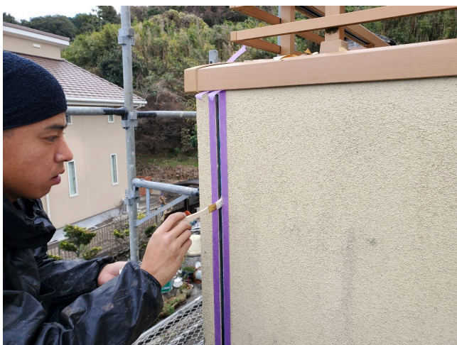
シール充填前 プライマー塗布
