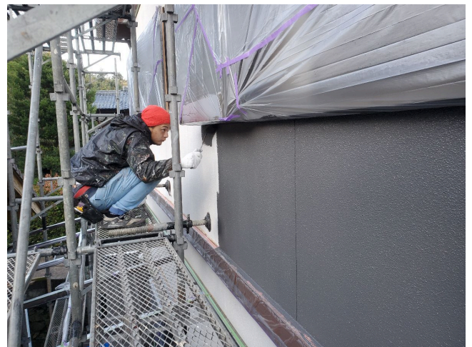
外壁 上塗1回目塗装状況
