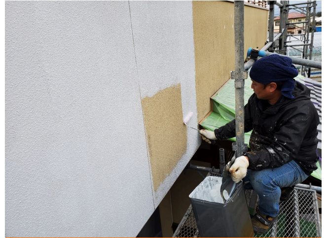
外壁 下塗塗装状況
