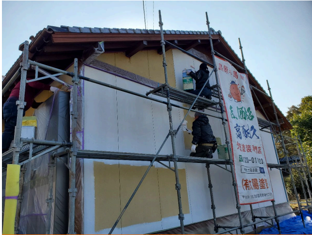
外壁 下塗塗装状況
