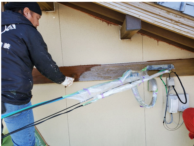
幕板木部 塗装状況
