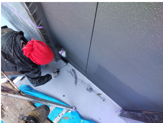
外壁 上塗2回目塗装状況
