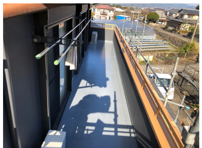
ベランダ塗装完了
