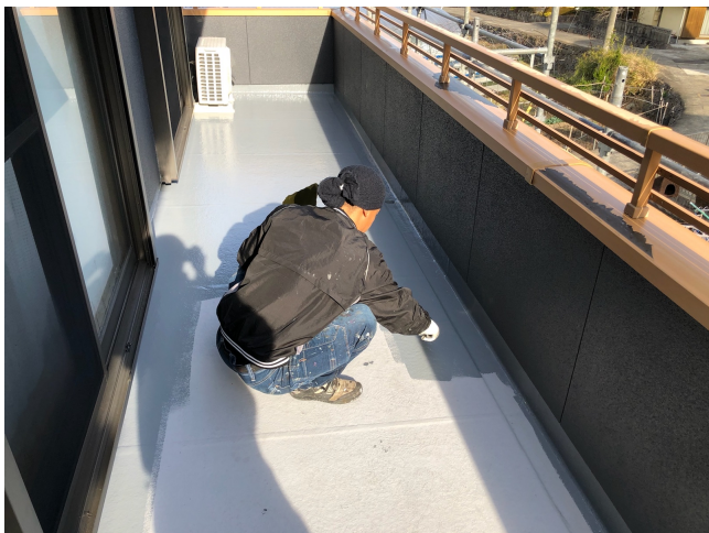
ベランダ 1回目塗装状況
