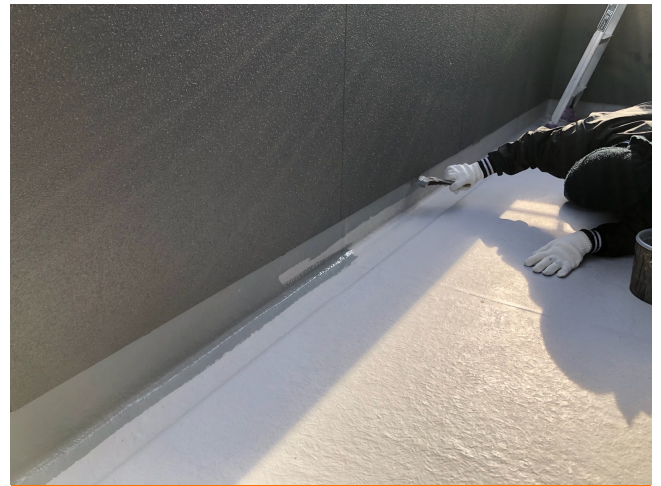
ベランダ 1回目塗装状況
