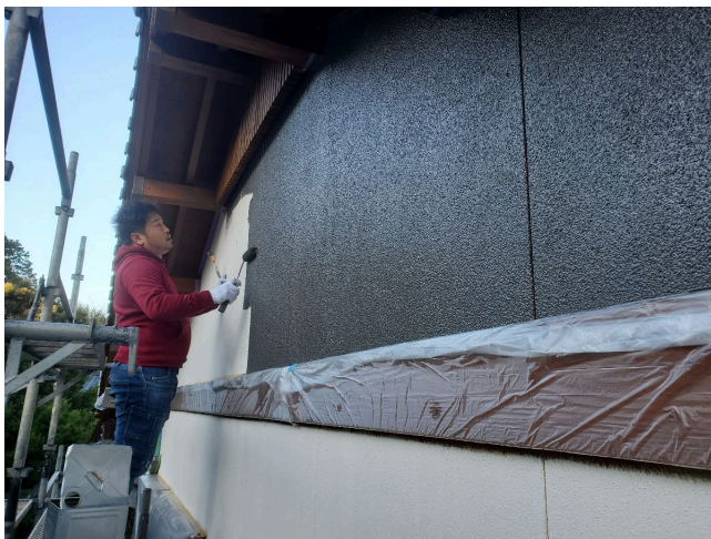
外壁 上塗1回目塗装状況
