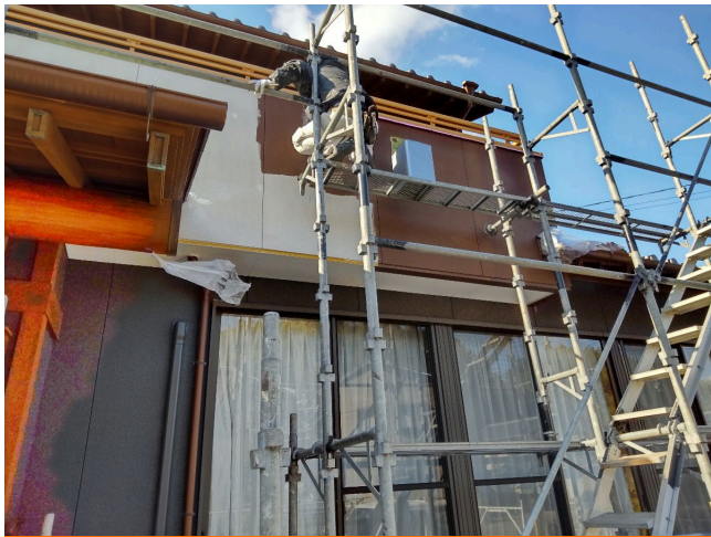
ベランダ上塗 1回目塗装状況
