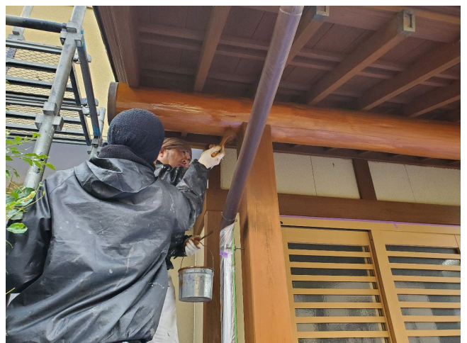
玄関廻り木部 2回目塗装状況
