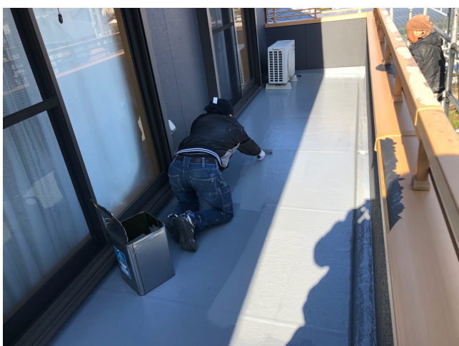
ベランダ 2回目塗装状況
