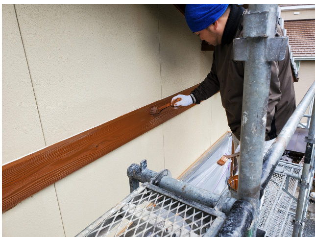
幕板 木部2回目塗装状況
